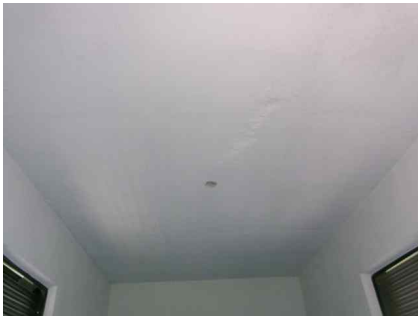
<계단실 내부 상부슬래브 상태양호>
