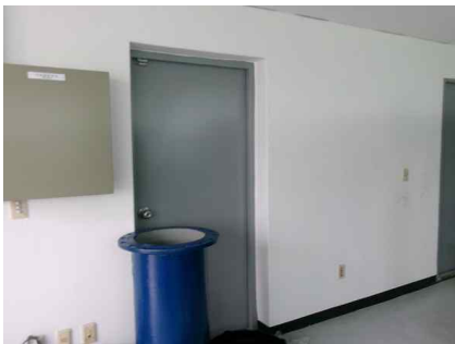
<관리동 내부 상태양호>
