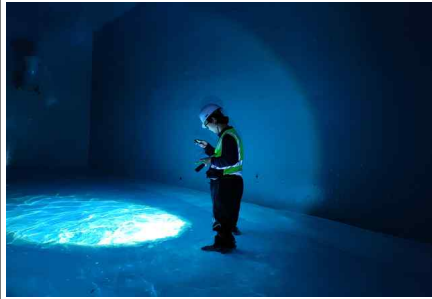
<내부 개별부재 외관조사>
