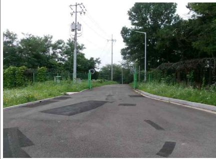
<진입로 포장 전경>
