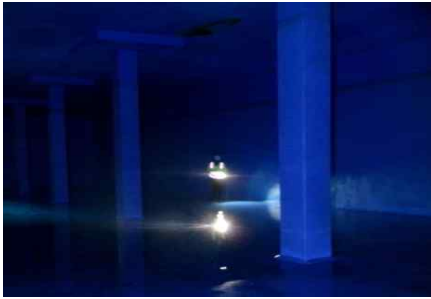
<내부 개별부재 외관조사>
