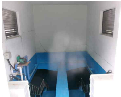
<계단실 내부 벽체 상태양호>
