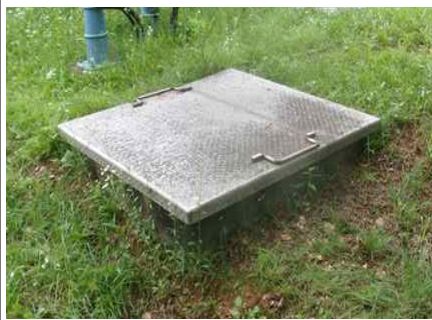
<환기구 등의 덮개(장비 반입구) 전경>
