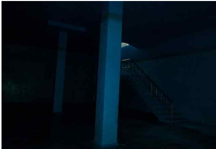
<배수지 1지 전경>
